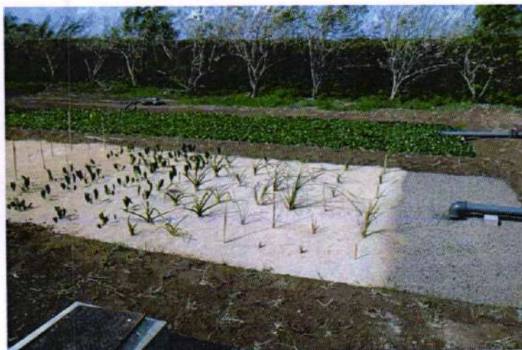
Exemple de filtres plantés en cours de plantation
