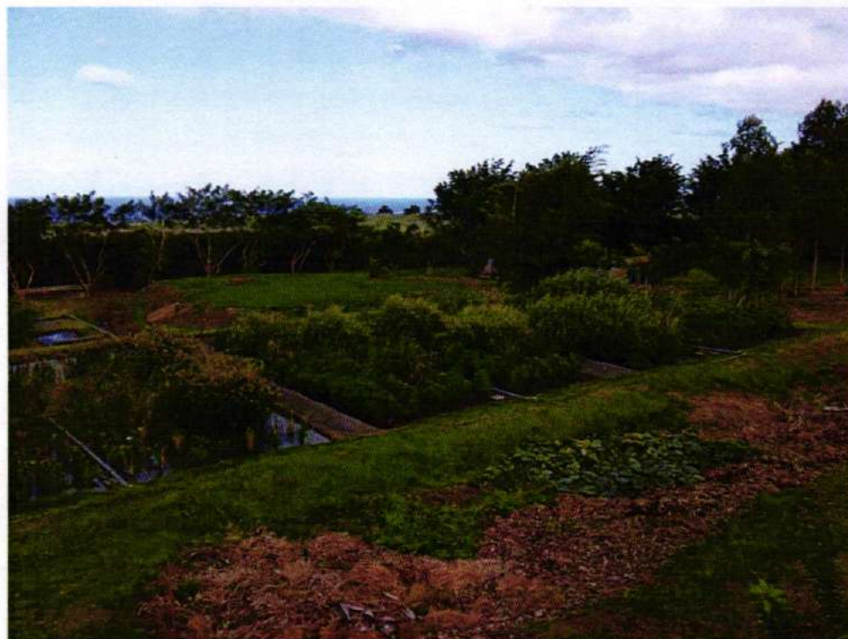
Exemple de filtres plantés développés
