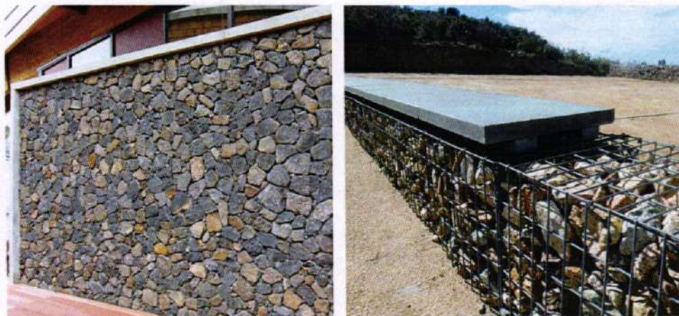
Mur soigné en galets éclatés/ mur gabion et assise
