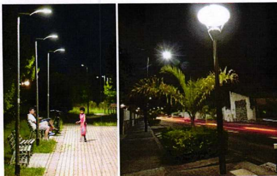
Luminaires d'éclairage et d'ambiance
