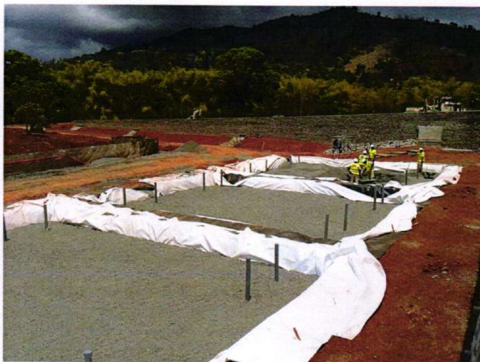
Filtres plantes en construction (Mayotte )
