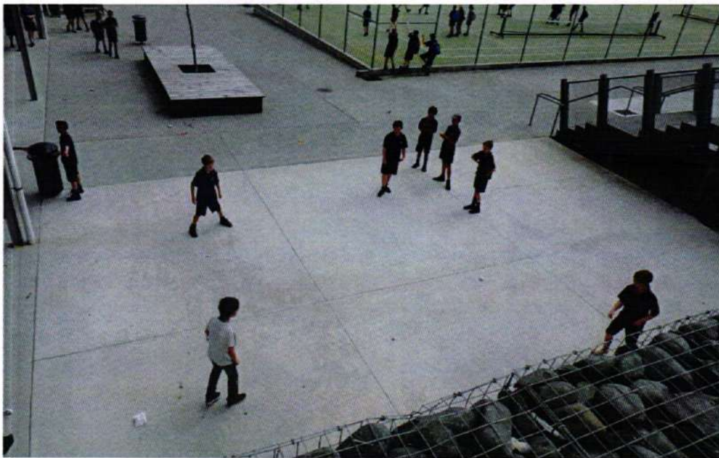
Cour d'école en béton avec joints engazonnés
